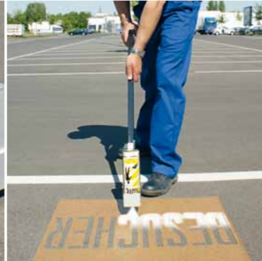
Wandnahe Markierungen mit Zubehörteil leicht möglich
